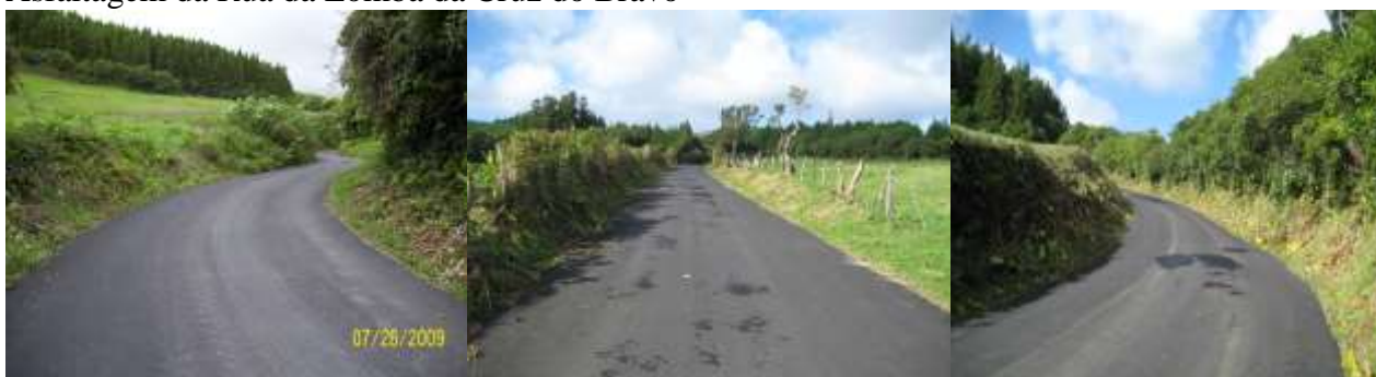
Asfaltagem da Rua da Lomba da Cruz do Bravo
