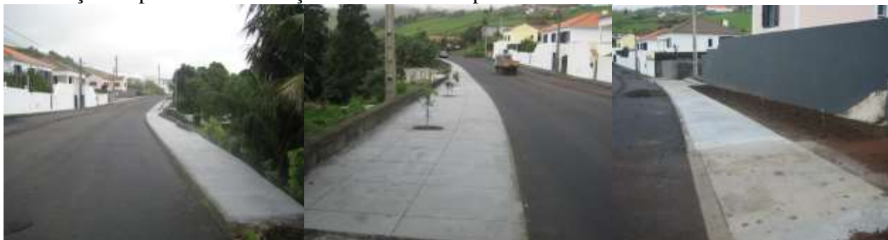
Construção de passeios e colocação de canteiros de plantas.
