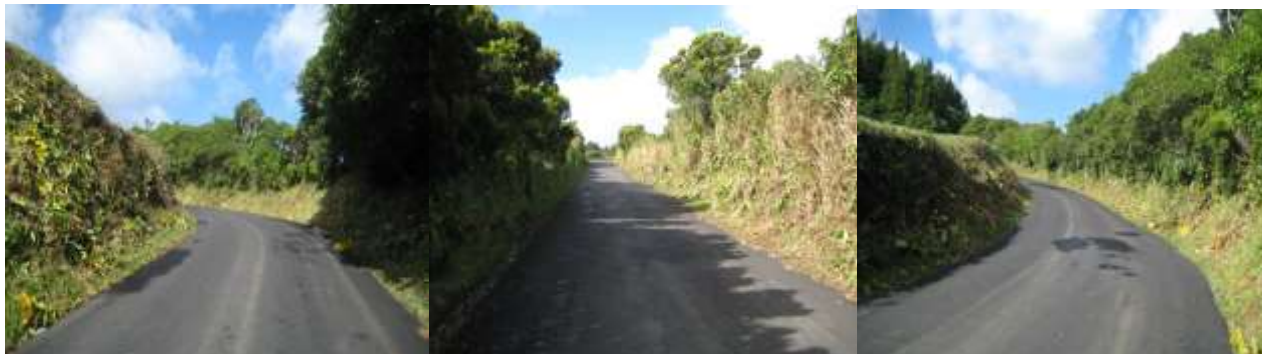
Corte e desbaste de bermas de estradas.
