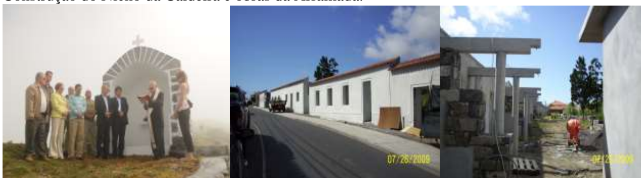
Construção do Nicho da Caldeira e obras da Arramada.
